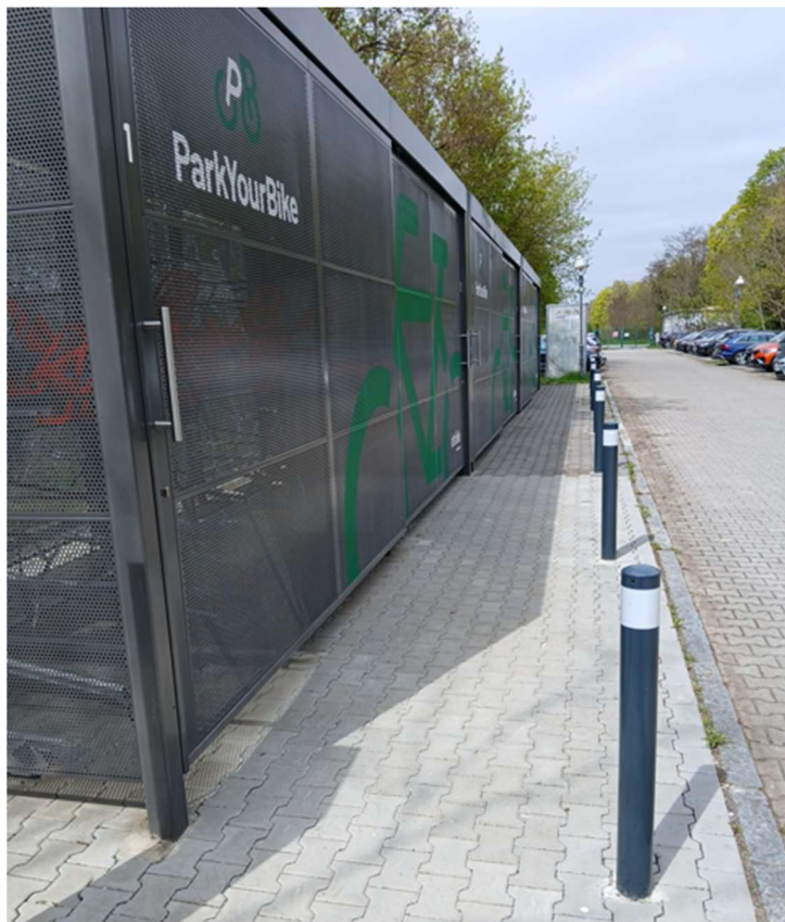
Abb. 4: Beispiel Sammelschließanlage in Hermsdorf mit davorliegender „Rangierfläche“
