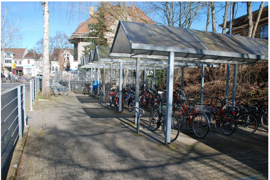
Abb. 2: Fahrradabstellanlage Nr. 03-011 mit Überdachung am S-Bahnhof Buch.
